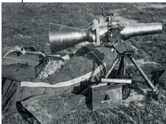
Рис. 2. Сброшенная на парашюте 76-мм ДРП распакована и собрана десантниками
