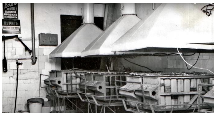
Рис. 2. Вытяжные зонты [3]
